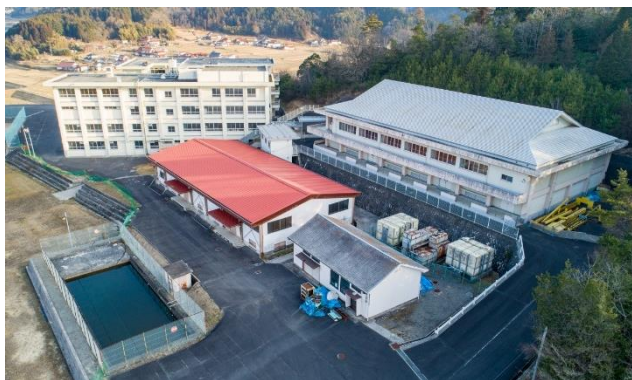
研修施設 世羅エデュケーションパーク (広島県世羅郡世羅町)
